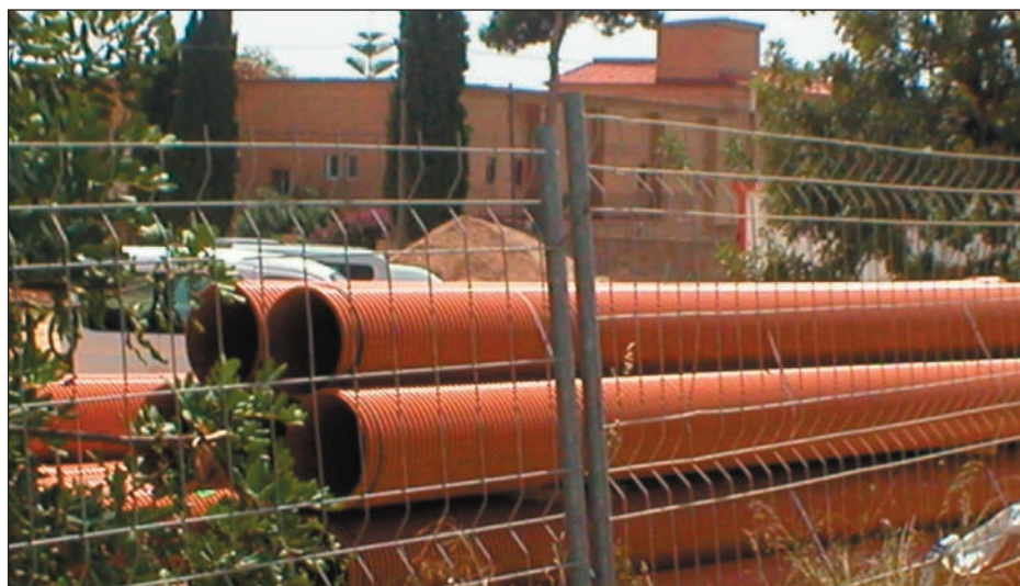
Obras en zona rural. Salida por Dominicos.
