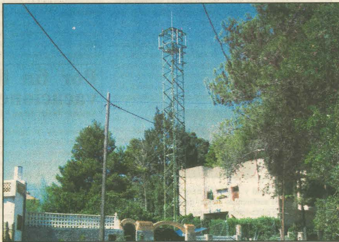
Vista de la zona residencial y la antena de telefonía
