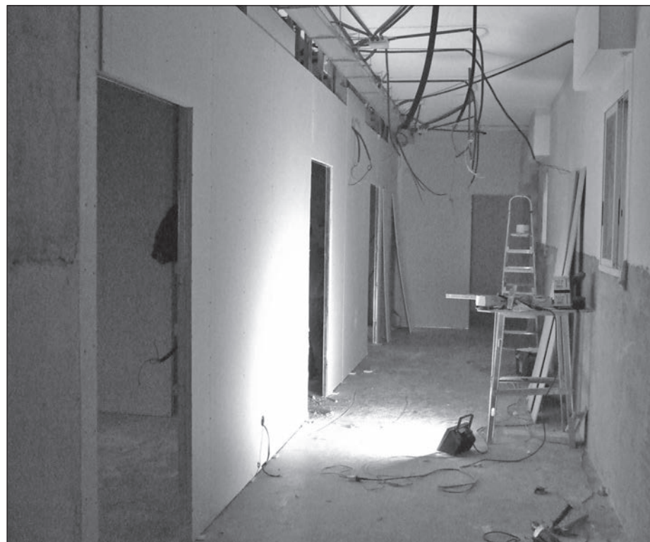
Imagen del interior del futuro consistorio donde se puede apreciar el comienzo de los trabajos.
