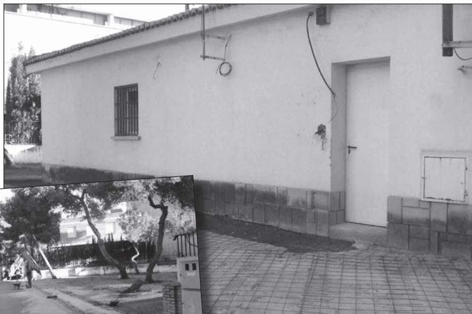
Las obras comenzaron en octubre y van según lo previsto.
