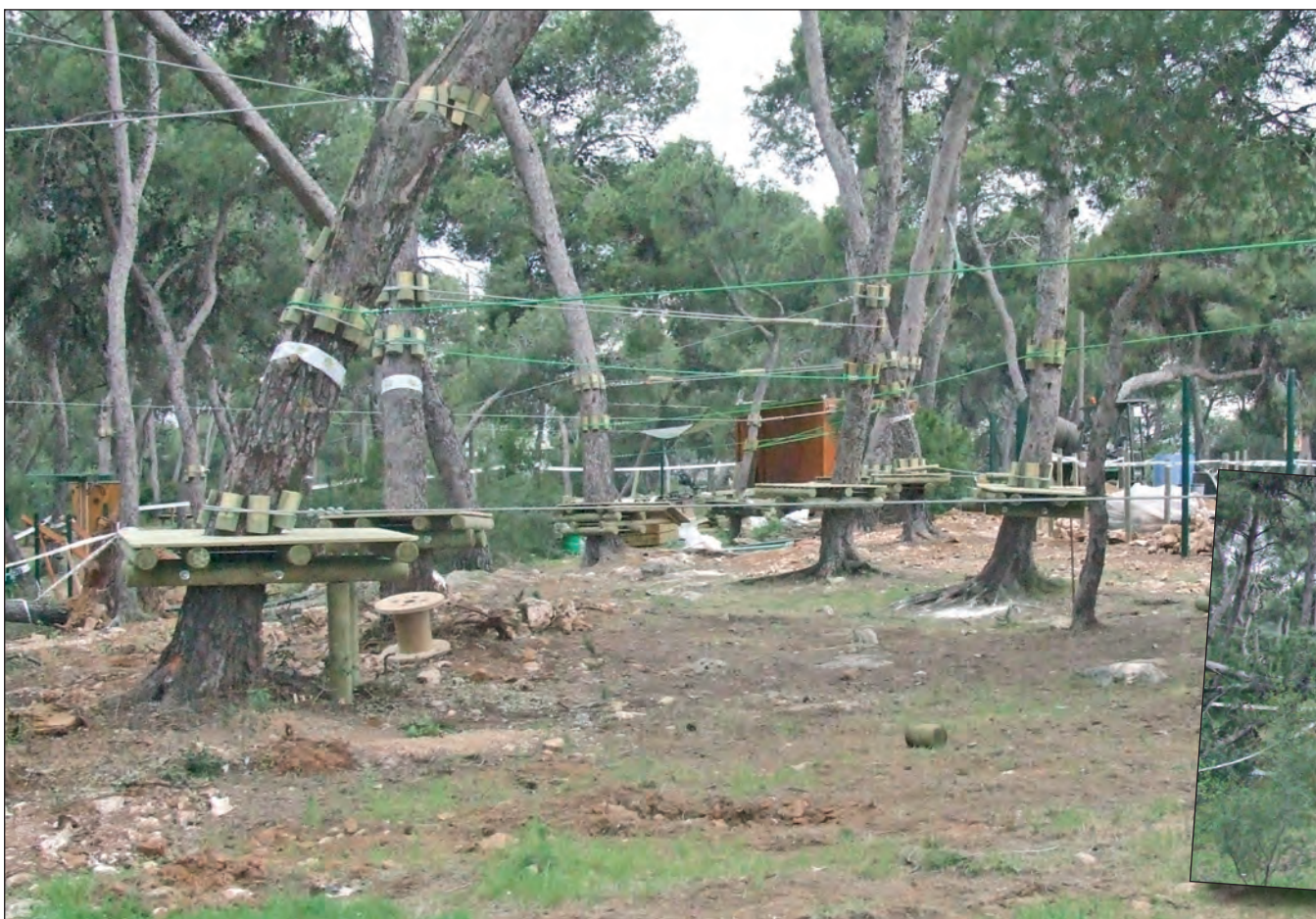
Vista parcial de las obras del circuito infantil.
