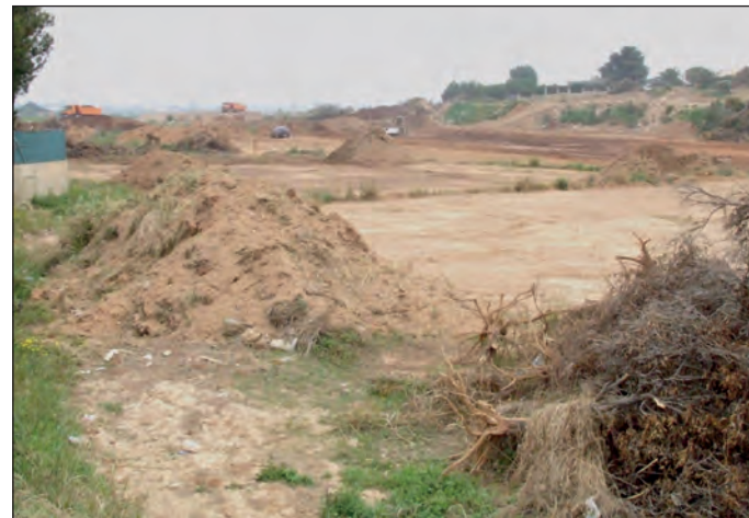
Ya han comenzado las obras del sector 10 de El Vedat.
