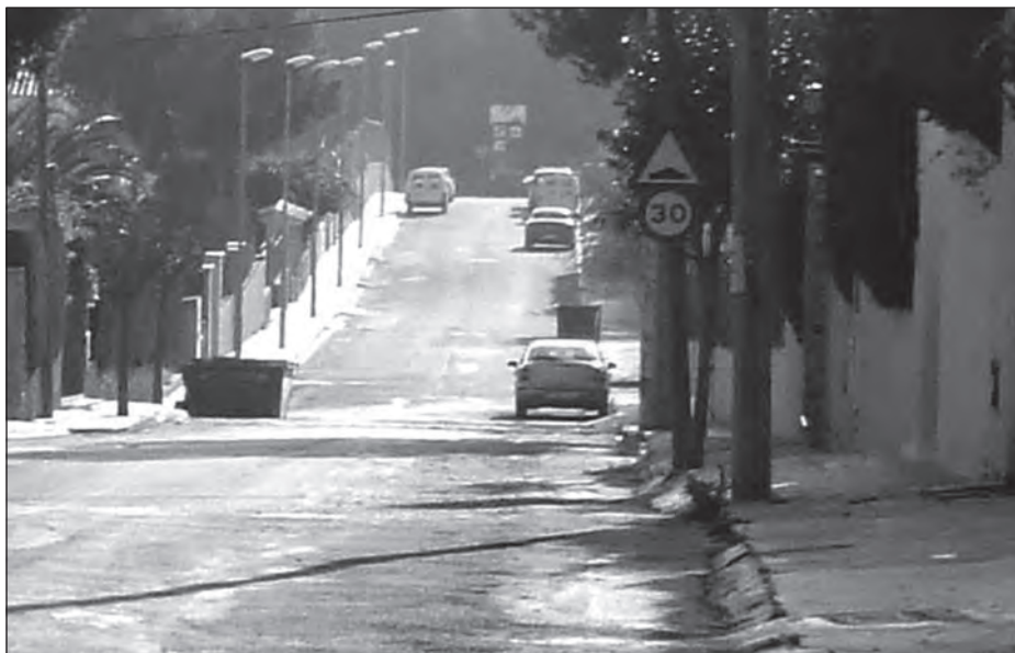
Vista de la calle Maestro Magenti, donde se ha renovado el alumbrado.
