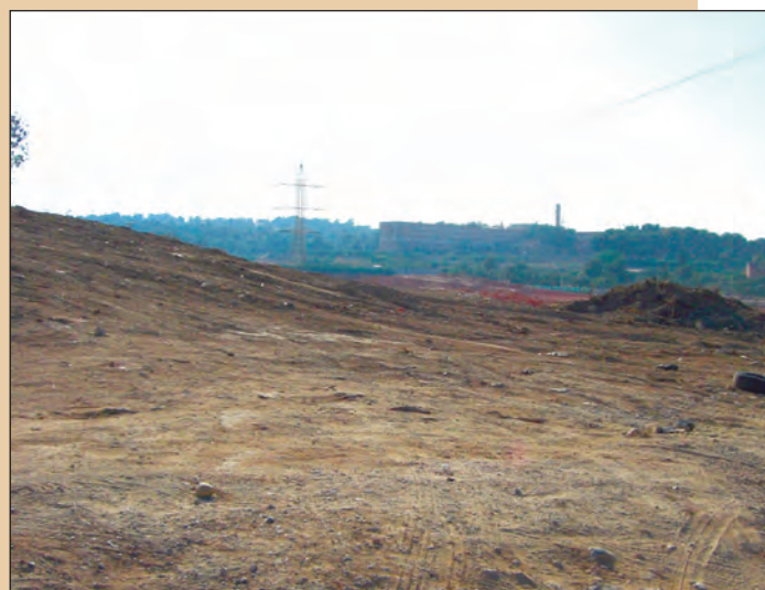
Obras entre Miramar y Santo Ángel.
