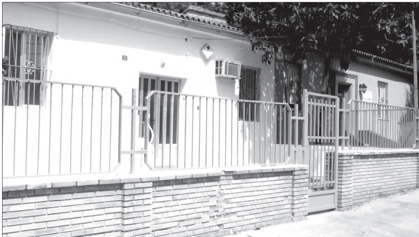
Acceso a las dependencias recién pintadas.
