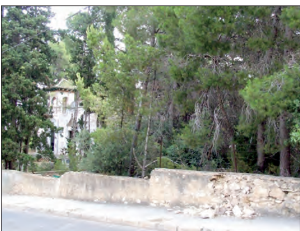
Av. San Lorenzo - Falta de limpieza.
