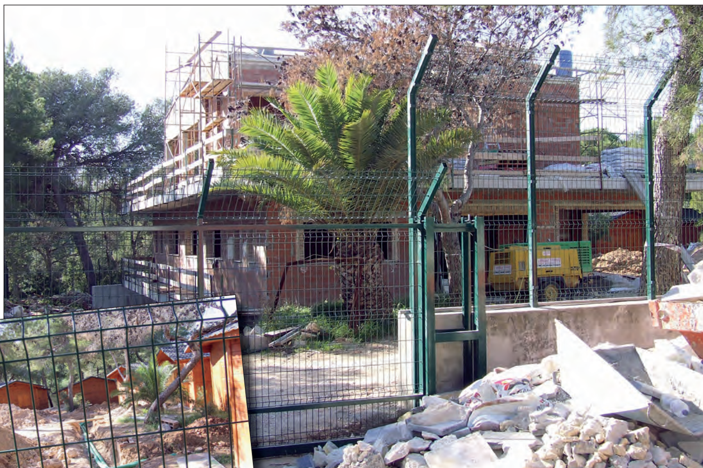
Estado actual de las obras en esta zona.
