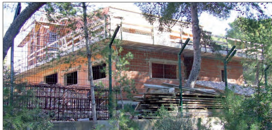
Vista lateral de la edificación.
