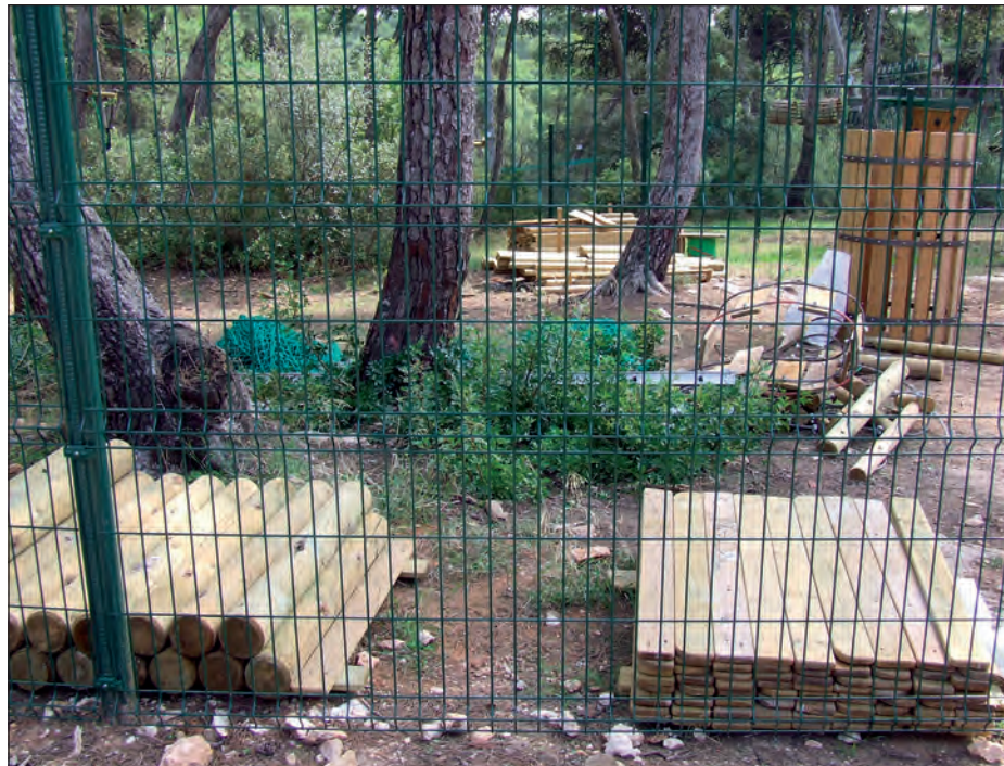
Zona vallada en proceso de desmantelamiento.
