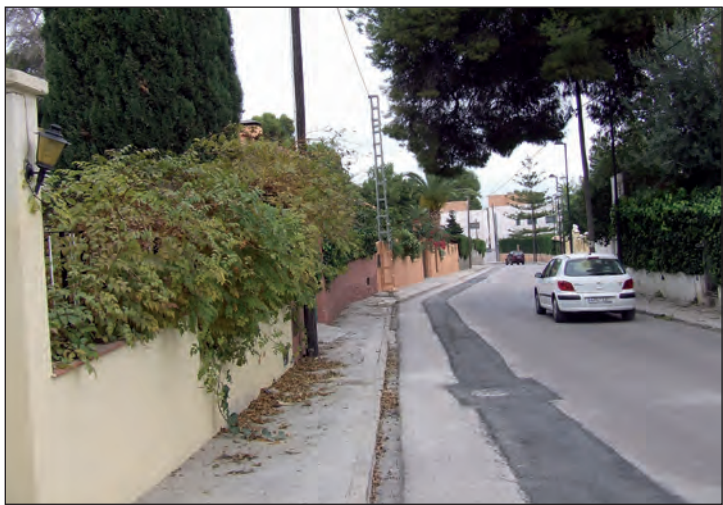
La calle Miramar está totalmente parcheada.
