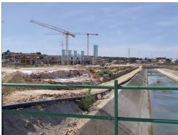
Las obras llegarán al Canal.
