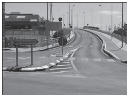
Acceso al puente.
