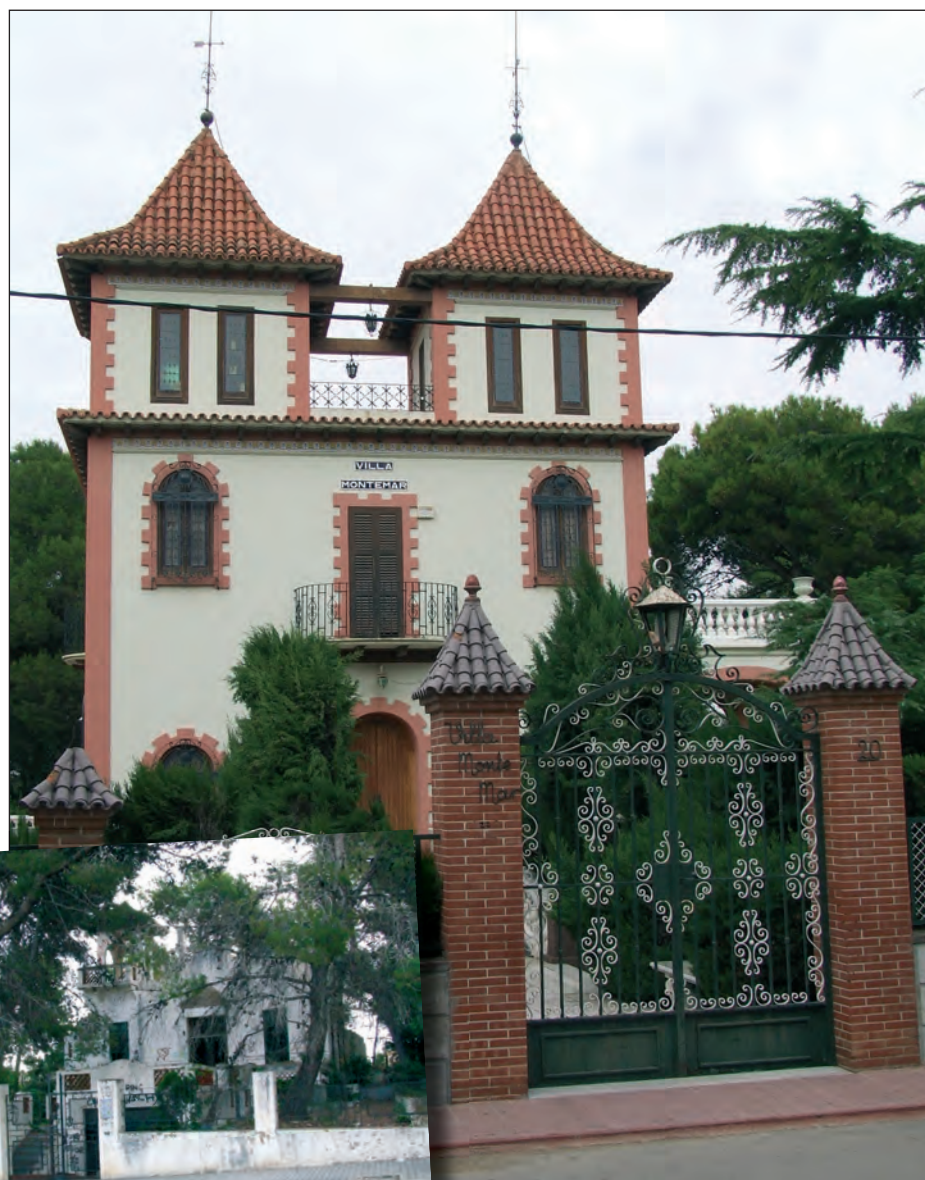
Arriba, Villa Montemar. A la izquierda, chalet antiguo abandonado.
