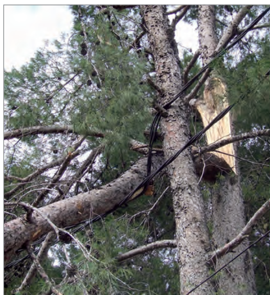
Alta tensión en El Vedat. ¡UFFF!
