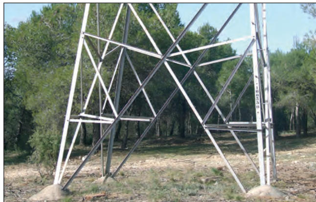
Vista de la zona "sana" de arbolado hasta el colegio "El Drac".
