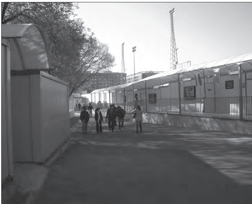
Aulas prefabricadas donde están algunos escolares del futuro colegio Nº 10.
