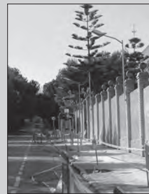
Ejecución del alumbrado.
