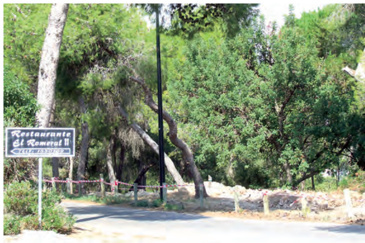
Zona de obras junto al Restaurante El Romeral.
