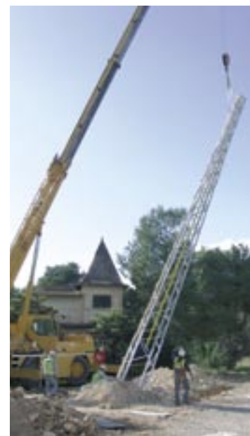
Instalación del último cañón.
