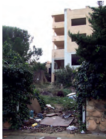
Aspecto de la rotura lateral del vallado.
