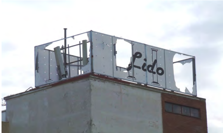
Desde el cierre del Hotel Lido se vienen produciendo los problemas de cobertura.
