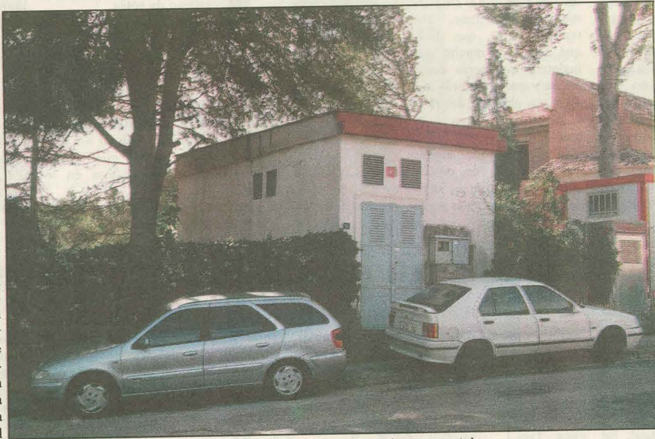
Casetas de alta tensión.... otro peligro potencial
