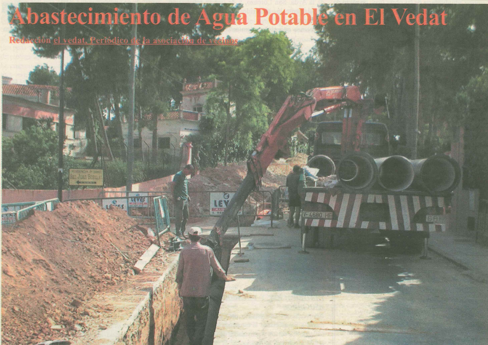
Inicio de las obras en la calle Doctor Fleming de El Vedat
