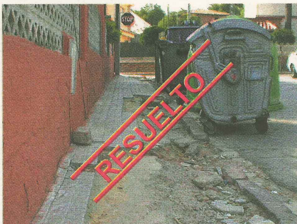
Acera de la calle Utiel en su primer tramo
