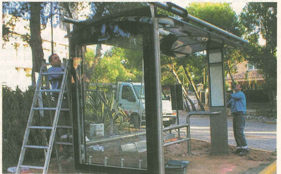
Dos operarios colocan una marquesina en la plaza de la Iglesia
