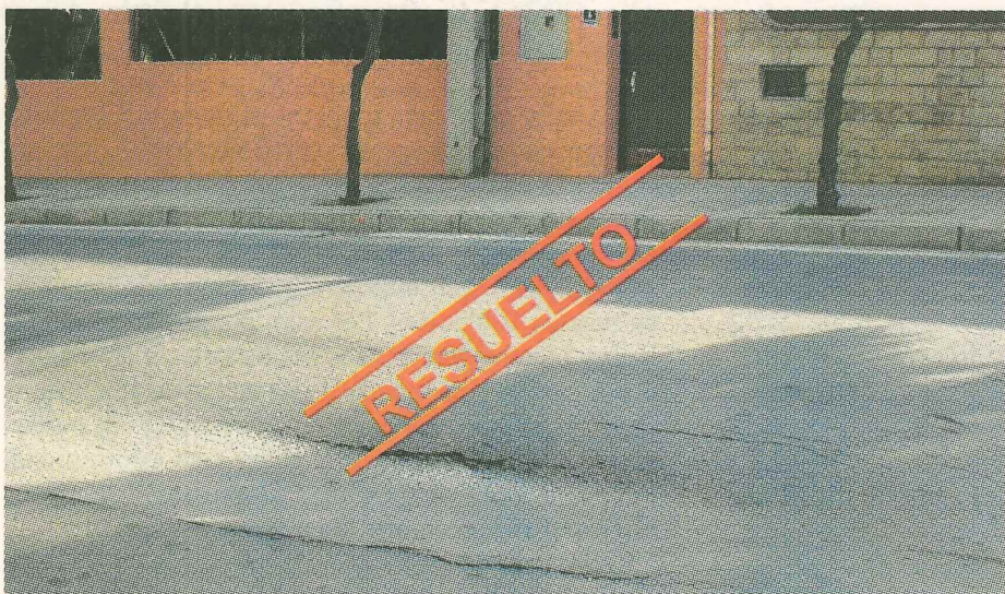
Badén reparado en la Avda. San Lorenzo
