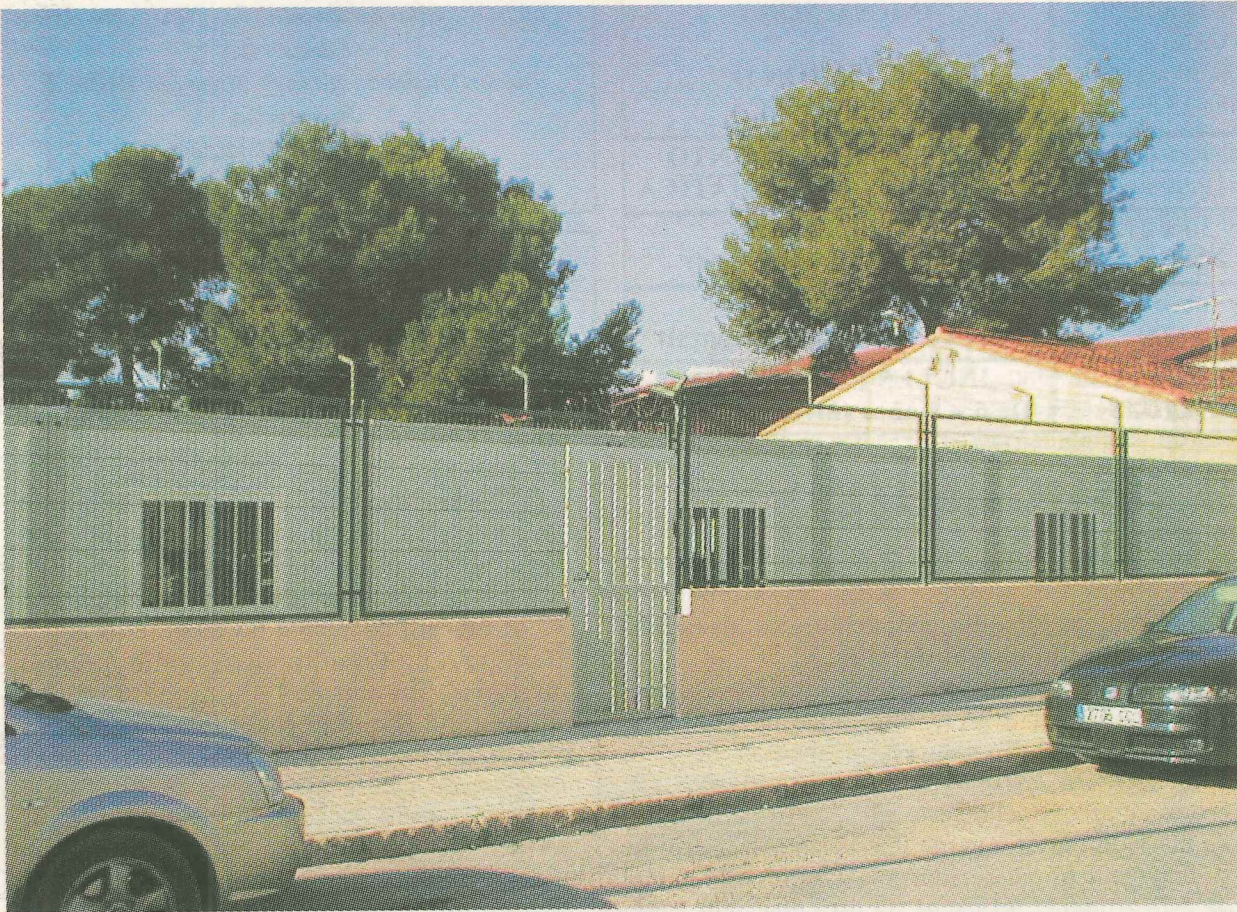
El CEFIRE trasladará sus equipamientos de El Vedat a esta aula dentro del C. P. San Juan Bautista
