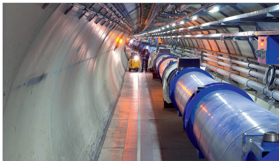
Vista del túnel del LHC donde, a la derecha, se puede apreciar el tubo del acelerador.
