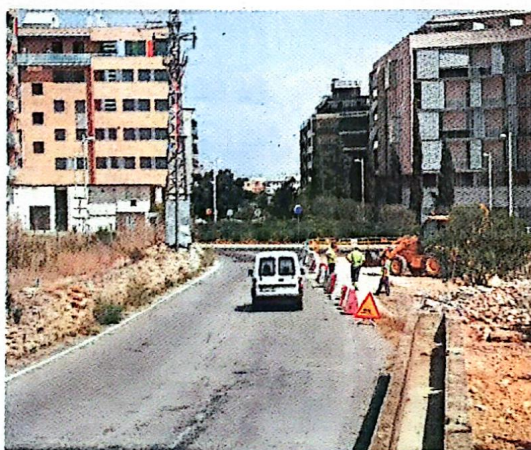
Estrechamiento de vía existente en el acceso al Parc Central desde El Vedat.
