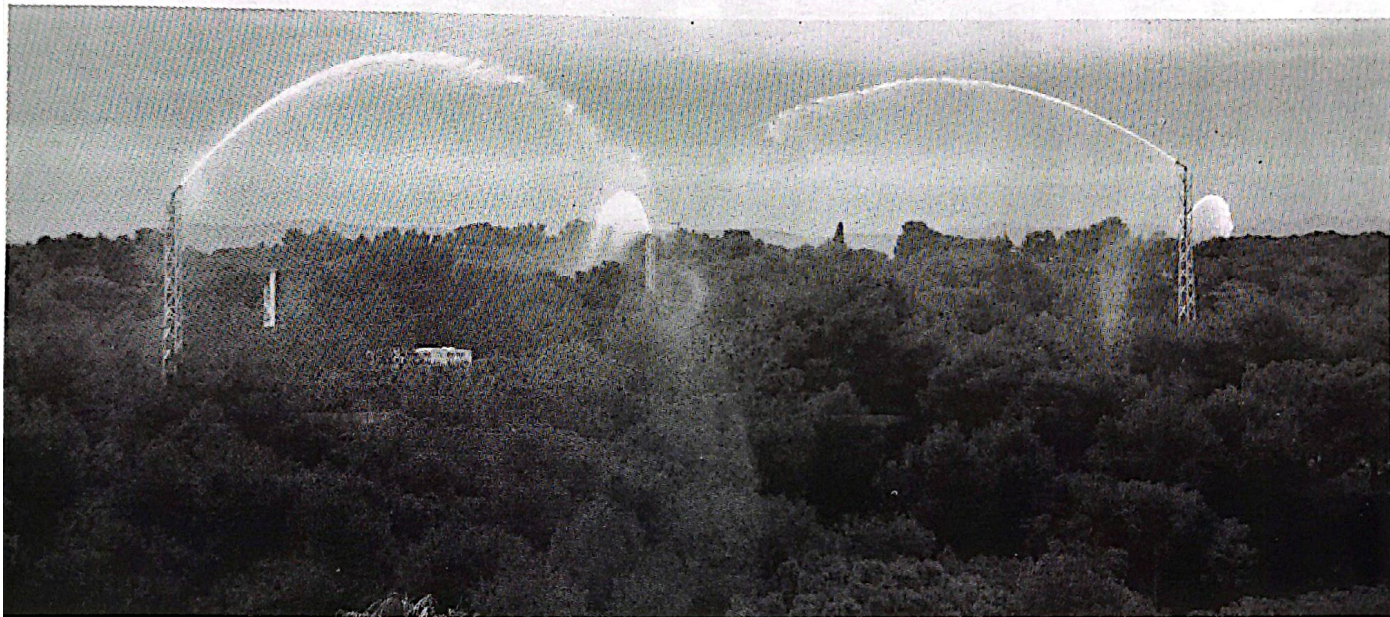
Cañones de agua domotizados, parte del SIDEINFO para la prevención de incendios en El Vedat
